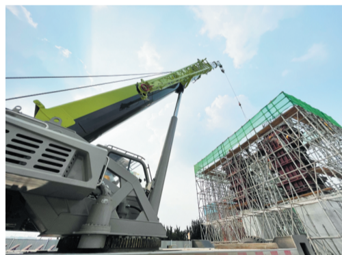
施工机械正在作业。
