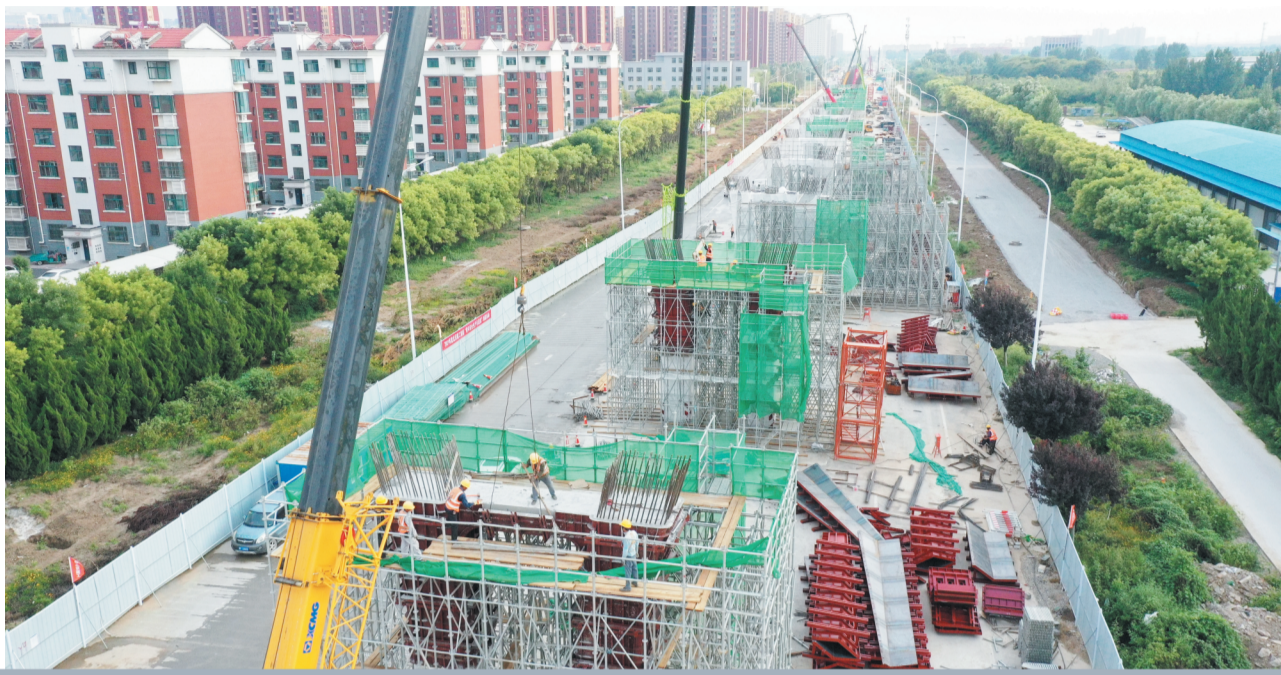
建设现场热火朝天。
