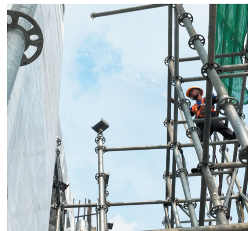
在项目现场,工人正在紧张施工。
