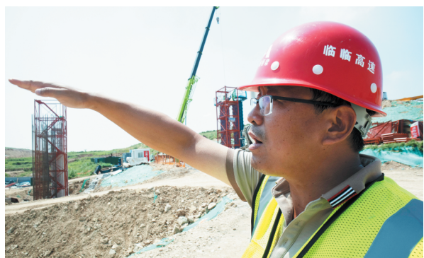
8月3日,临临高速二标段一分部项目经理刘敏向记者介绍施工进展。
