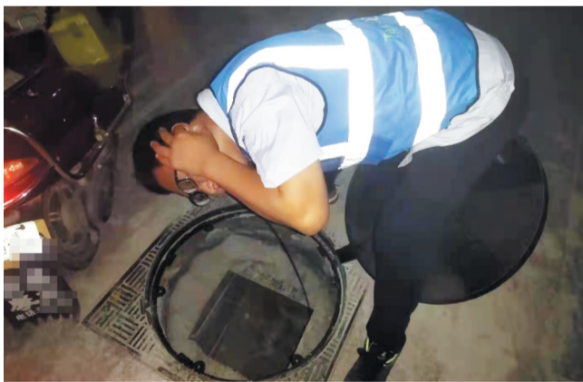
深夜,刘伟查找管网测漏点。
