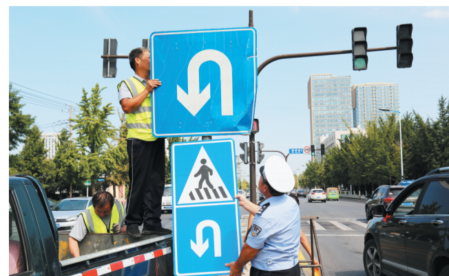
改造道路交通设施,营造畅通出行环境。
