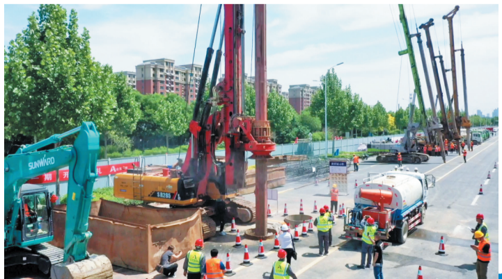
淄博城市快速路网开钻现场
