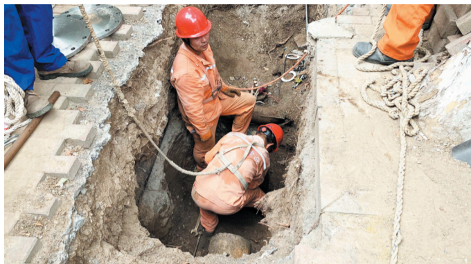
施工人员进行作业。
