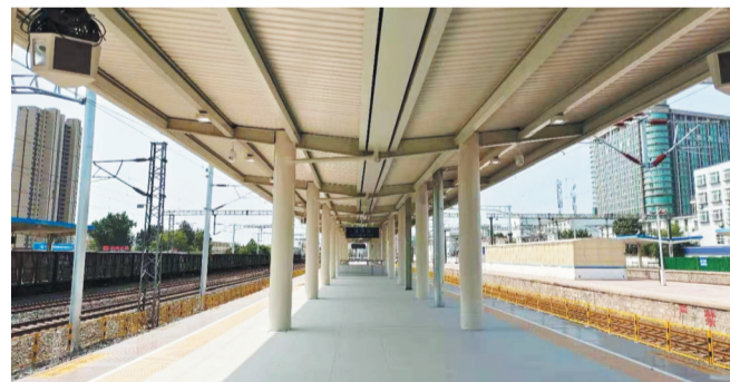
淄博站客运设施改造工程第一阶段工程现场(8月25日摄)
