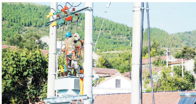
9月2日,国网淄博供电公司工作人员在博山区乐瞳村实施“煤改电”工程。
