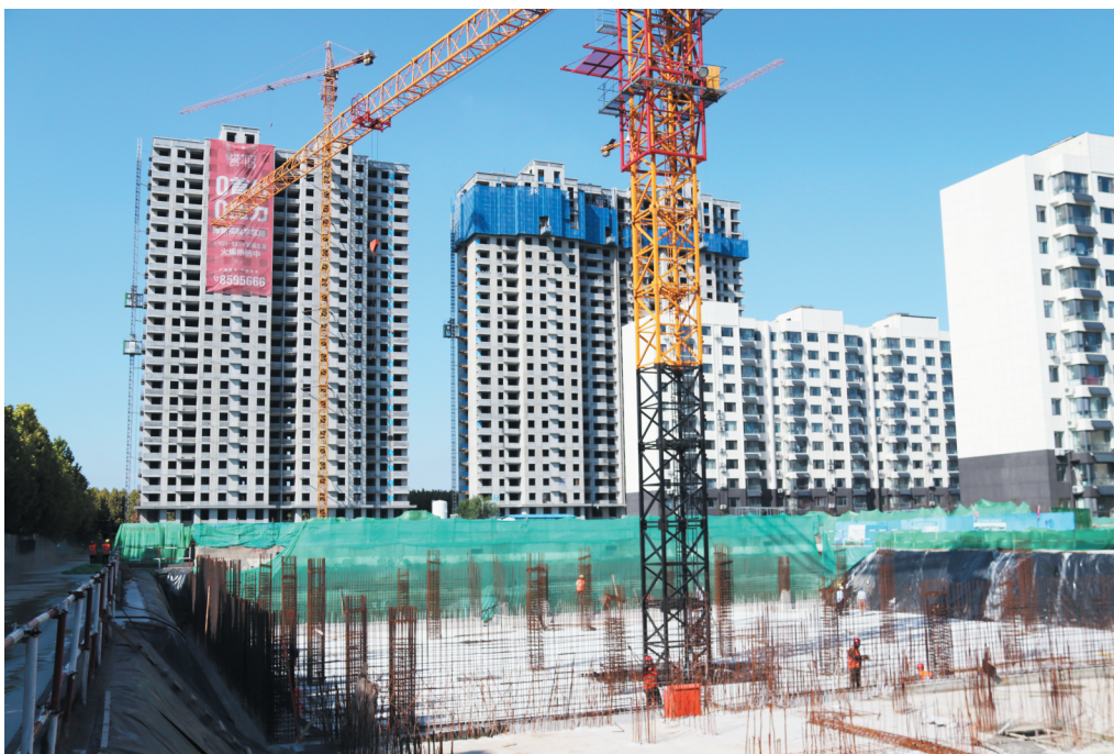
施工现场安装了旋转式高空高压水雾降尘系统。
