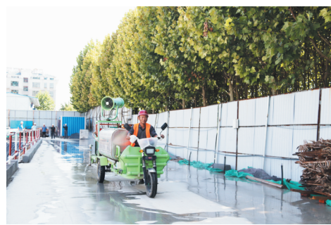
洒水车沿着硬化道路进行洒水作业。
