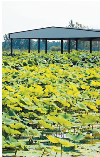
荷虾共生小龙虾基地中,龙虾体验馆正在建设。
