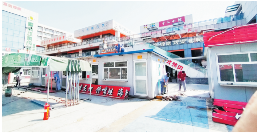
工人正在拆除美食广场上的设施。
