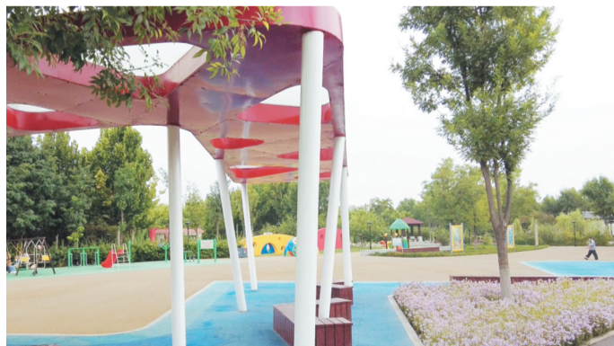
小小廊道戴上“雨帽”，变成游园市民避雨赏雨的好去处。
