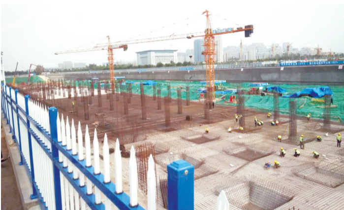
左图:淄博文化中心基坑支护工程
