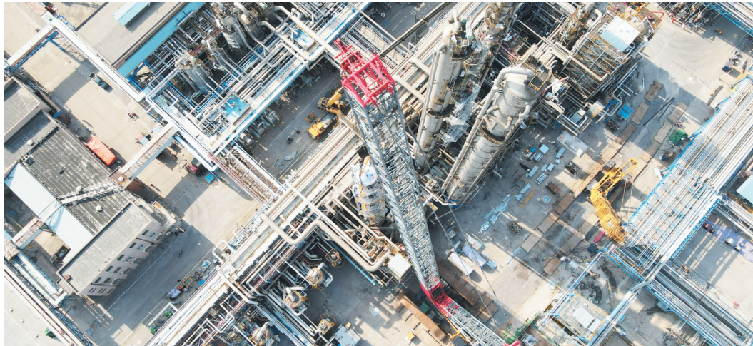
鸟瞰齐鲁石化烯烃厂脱乙烷塔新塔吊装现场 通讯员 马钊 摄
