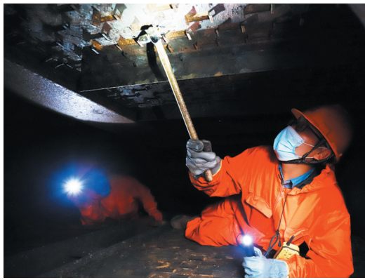
齐鲁石化炼油厂设备鉴定组人员在塔器内测量塔壁厚度。 通讯员 王斐 摄
