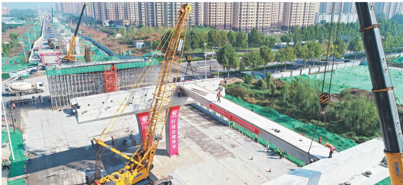
随着施工人员稳稳地将一片长27.48米、重90.92吨的预制箱梁架设在第83跨上,淄博城市快速路网工程首片箱梁架设成功。
