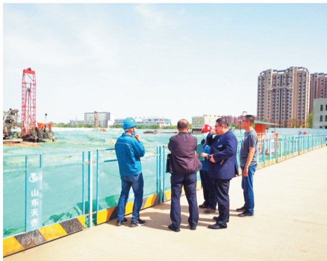
水电暖信等专营单位工作人员到工地上进行联合踏勘。
