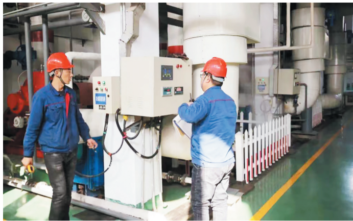
淄博市热力集团有限公司技术人员正在调试工业余热供暖设备。
