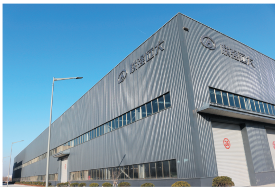
联强住工装配式建筑生产基地一角
