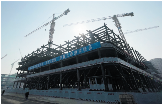
青岛科技大学淄博教科产融合基地是淄博市第一个全部采用装配式建筑的大型公建类项目。
