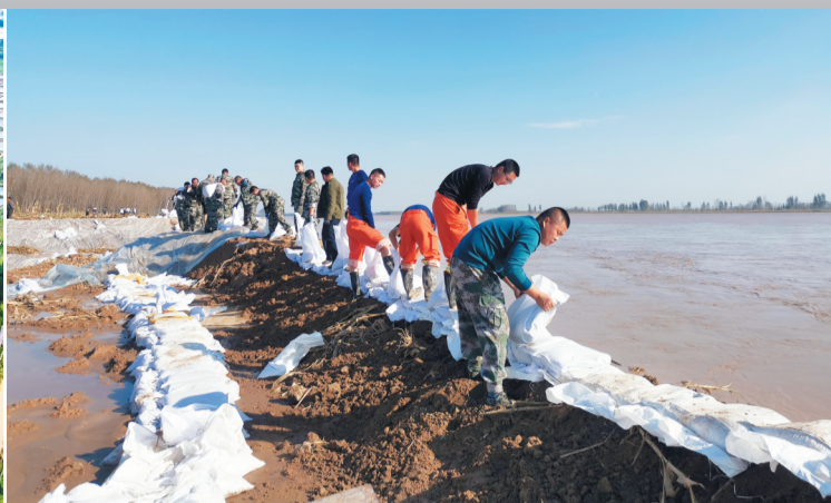
防汛人员加固堤坝。
