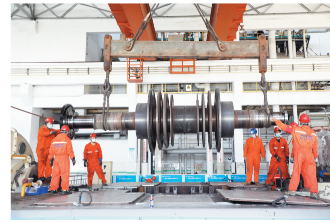
公司4号机组高背压转子更换工作现场
