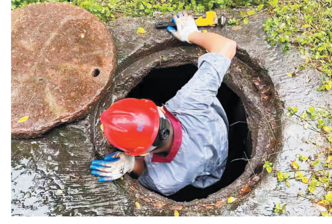
华星热力工作人员雨天检查小区供暖井漏水情况。
