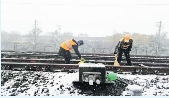
7日,淄博车务段管内各站干部职工对各咽喉道岔区的积雪进行清扫、喷涂防冻液,确保行车设备的正常使用。 大众日报淄博融媒体中心记者 孙渤海 通讯员 梁兆福
