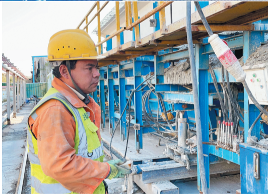
11月9日,梁场内,施工人员正在作业中。
