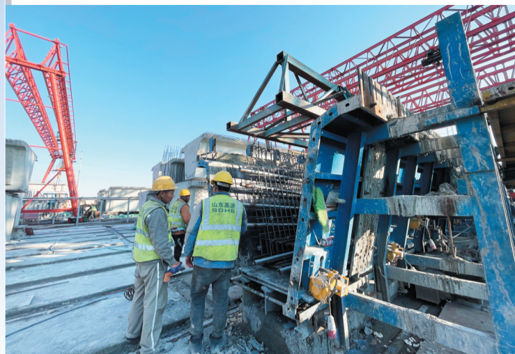
11月9日,鲁泰大道项目三分部梁场内施工人员正在工作。
