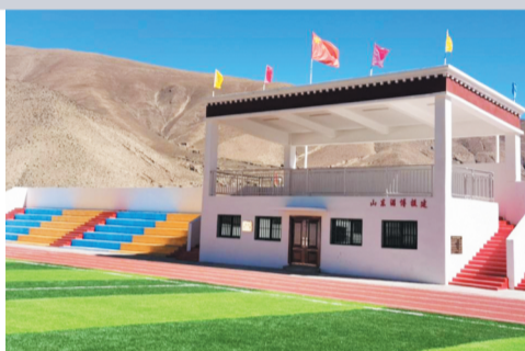
多白乡小学运动场竣工实景图
