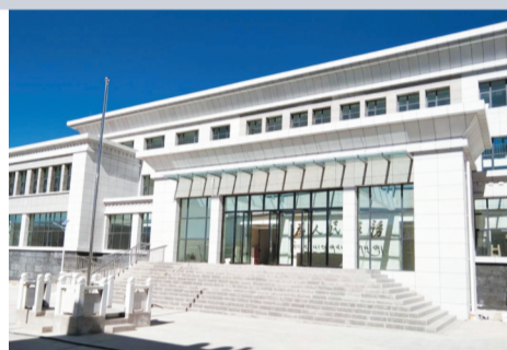
昂仁县农牧业综合服务中心竣工实景图
