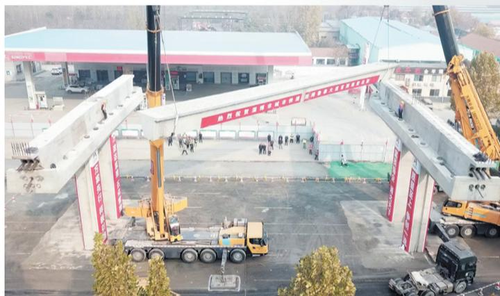
11月17日,在淄博城市快速路网鲁泰大道项目施工现场,随着施工机械稳稳地将一片长30米、重100吨左右的预制箱梁架设在第55跨和第56跨上,淄博城市快速路网鲁泰大道项目首片箱梁架设成功。这标志着该工程正式迈入上部结构施工阶段。当天,相关人员立下“军令状”,确保年底前部分路段主线桥实现贯通。
