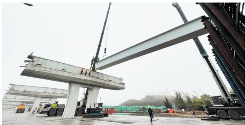
大程度上保证路口东西方向车辆通行不受影响，施工难度相对更大。”现场，淄博市城市快速路网建设工作专班穆守峰介绍，伴随着中润大道路口带交通作业的顺利完成，沿线路口钢箱梁吊装的又一难关已经攻克，工程建设朝着预期计划又迈进了一大步。
