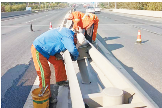
施工人员正在对路中间隔离护栏进行维修。
