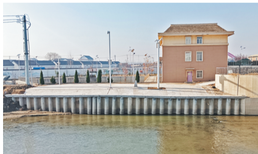
东猪龙河道施工首次采用波浪桩护坡护岸。
