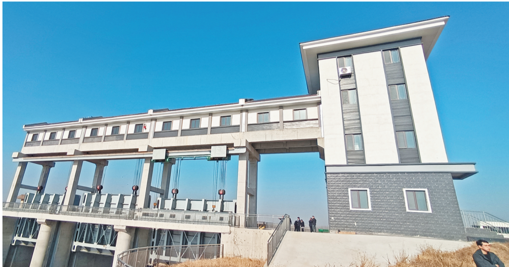
东猪龙河闸位于东猪龙河入小清河处。
