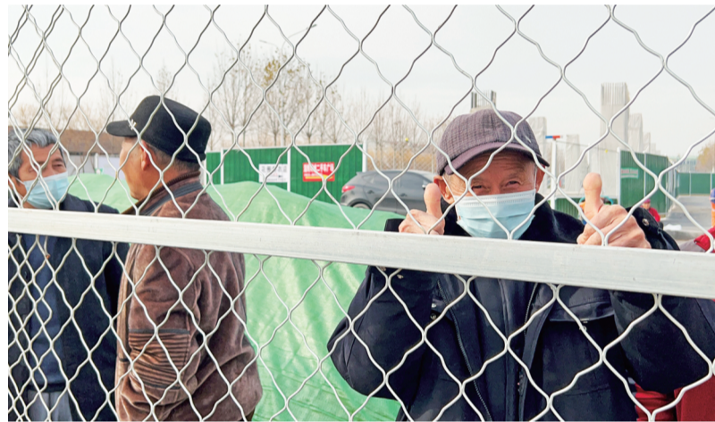
目睹吊装过程的市民为快速路建设点赞。
