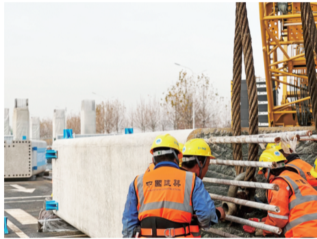
施工人员进行吊装前的准备工作。
