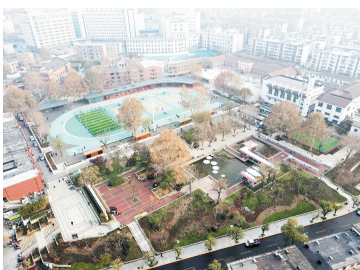
提升改造后的淄博市工人文化宫(无人机照片)
