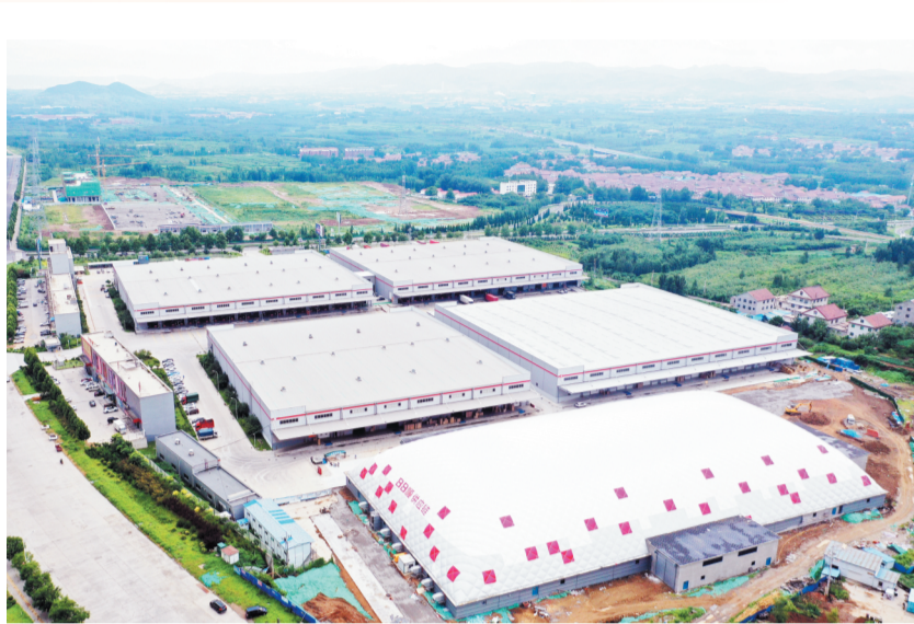
海尔新星物流公路港项目
