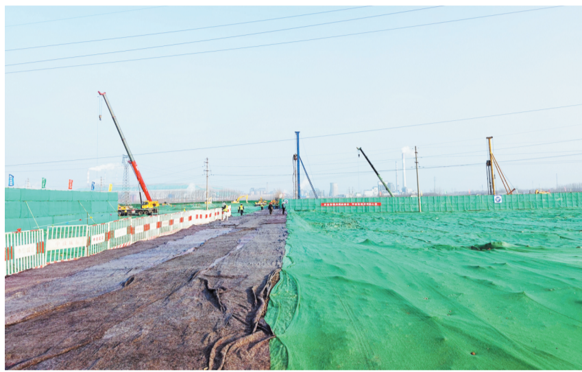
保税物流中心施工现场
