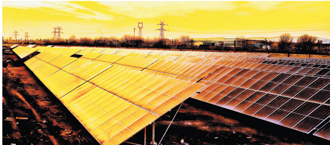
经过两个月奋战,齐鲁石化光伏发电一期建设项目的18824块太阳能发电板已全部安装完毕。夏东明 摄
