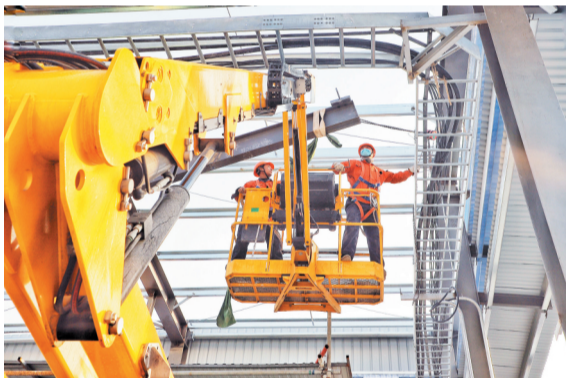
11月29日,齐鲁石化氯碱厂氢气压缩充装项目中交。夏东明 摄
