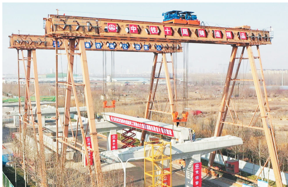
龙门吊进行吊装。
