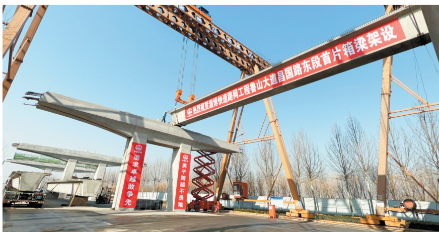
箱梁吊装成功。
