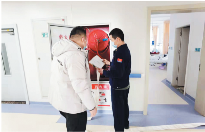
监督检查人员查看医院消防器材检查记录。
