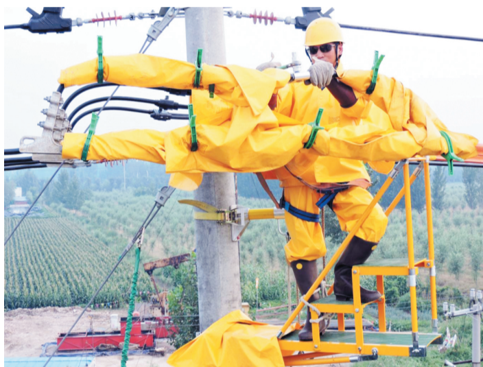
工人在阶梯式绝缘平台上施工。
