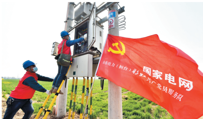
国网桓台县供电公司工作人员开展隐患排查工作。
