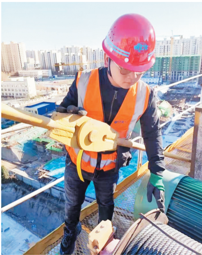
柯钦正在检查塔吊。
