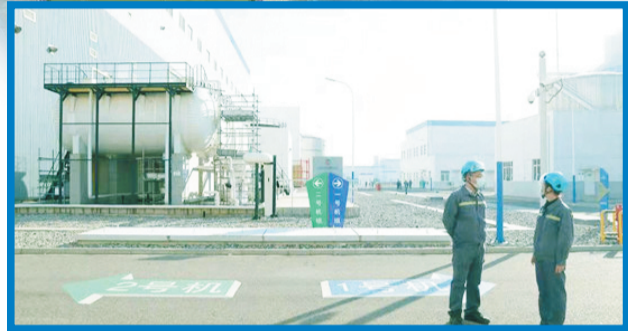
在海阳核电站，两个机组用不同的颜色区分，最大程度避免操作失误。
