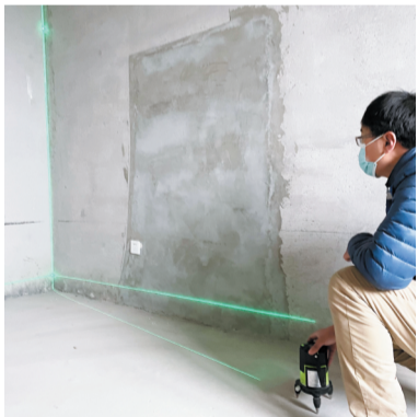
验房师正在检查墙角顺直度。
