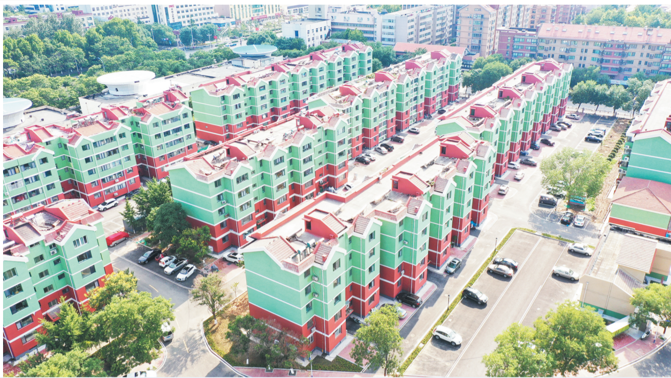
改造后的临淄金茵小区。
