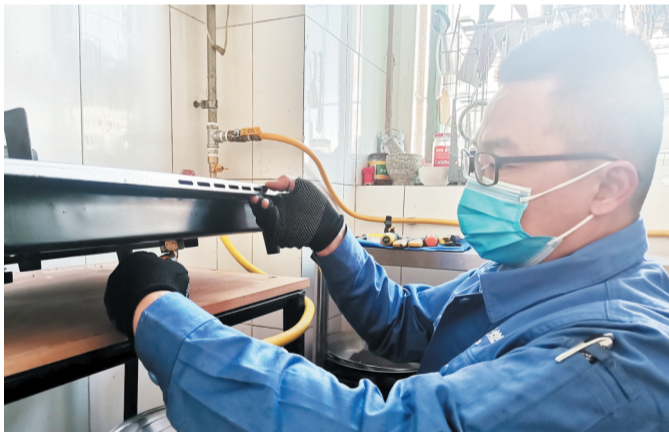
2月22日,淄博华润燃气有限公司维修工宁波正在杜科生活区居民家中更换长寿命金属软管。
