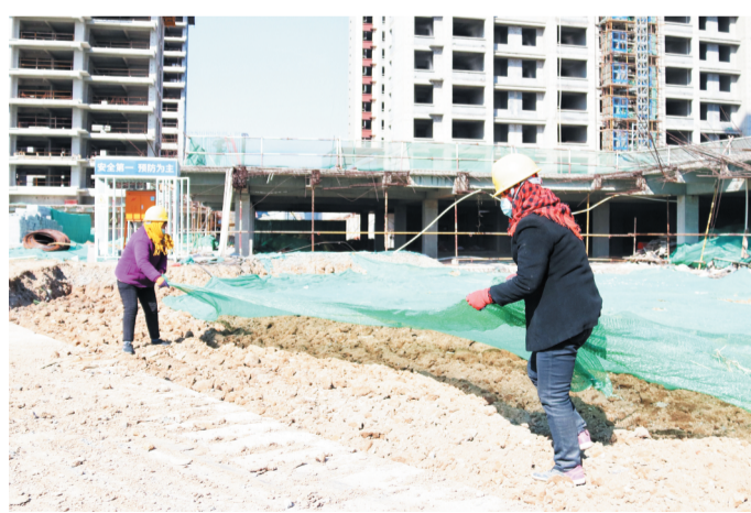
工人用防尘网对裸露土地进行覆盖。
