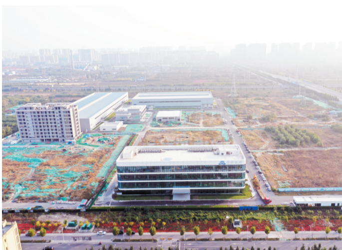
张店经济开发区大体量优质项目正在建设中。
