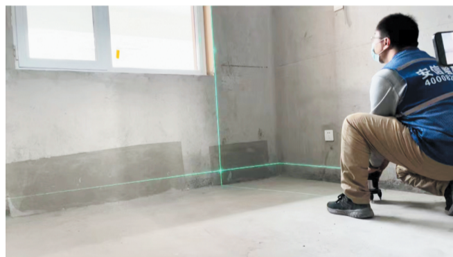
验房师在测量墙面顺直度。
