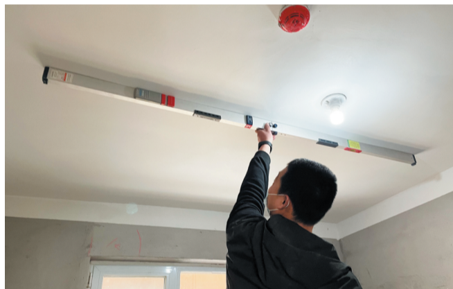
验房师测量顶面平整度。
