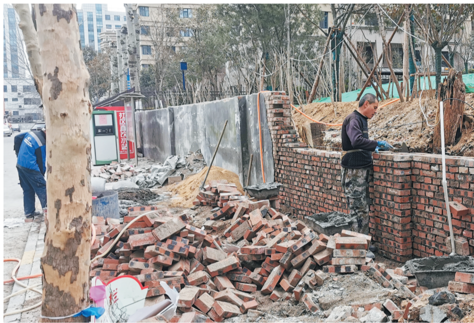
施工人员正在紧张忙碌地进行着危墙翻新工作。
