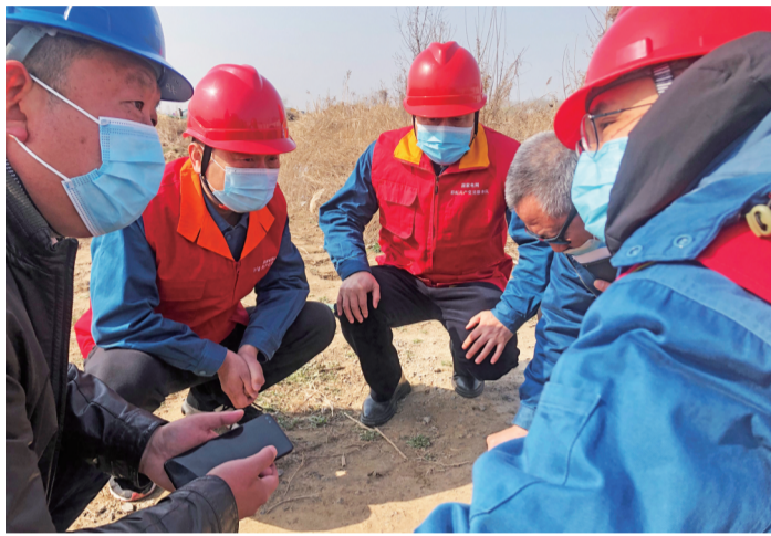
国网滨州供电公司配电工程公司党支部书记带领工作人员商讨疫情防控点电源接入方案。
