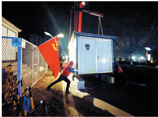
国网滨州阳信县供电公司彩虹共产党员服务队星夜奋战6小时，为全市首个核酸检测实验室安装630千伏安箱变1台。
