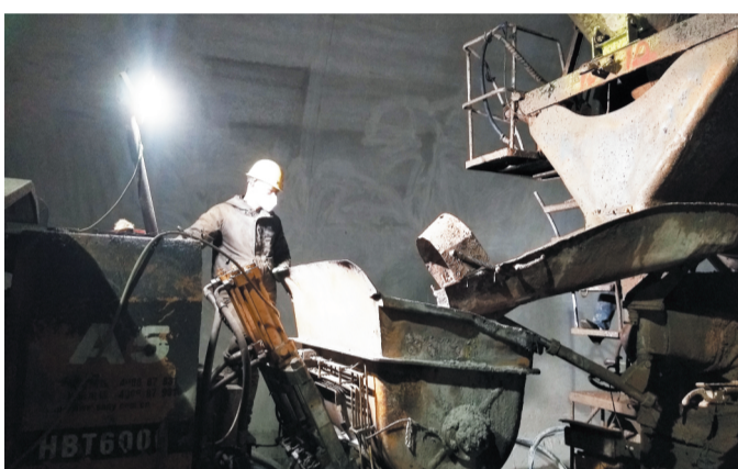
龙凤山隧道里，工人正在进行浇筑施工。
