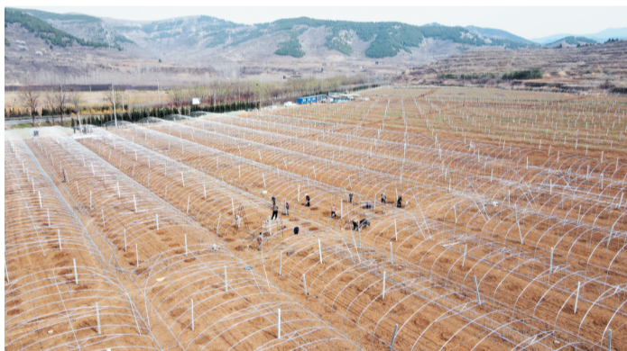
果宝鲜生智慧农业产业园项目正在施工。
