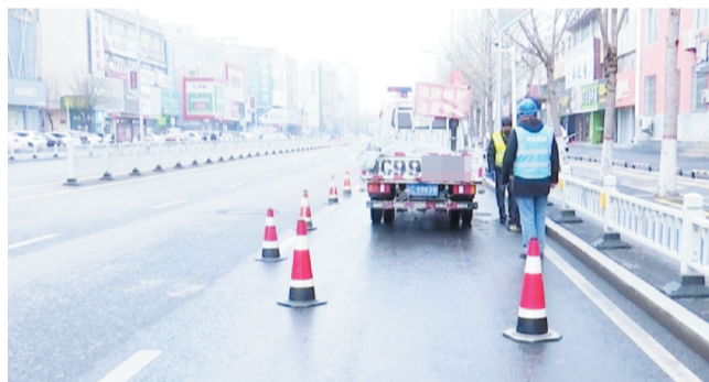
临淄区市政园林环卫事务服务中心市政工作人员进行清淤。
